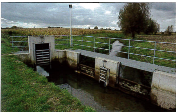
De Belselebeek wordt door de sluis voor een deel afgeleid in de Armentruyenbeek.
