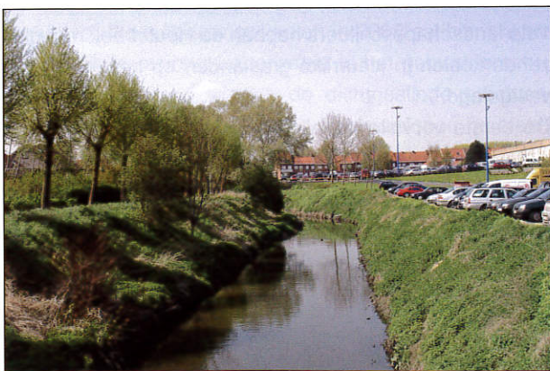
Rechttrekking Heulebeek en ophoging oevers voor woonverkeveling (links) en parking (rechts) van Shopping Center Kortrijk Noord dat in 1973 gebouwd werd. Foto Luc Soens.
