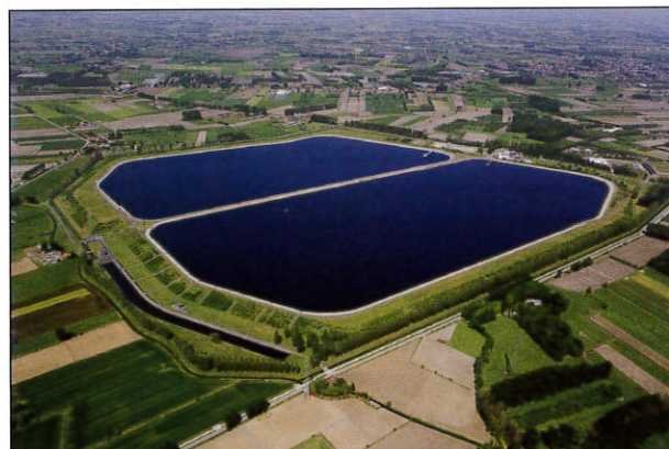
De spaarbekkens van Kluizen: 11 miljoen kubieke meter oppervlaktewater als grondstof voor lekker en gezond drinkwater.
